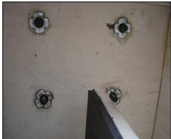
Imagen 13.19 (izquierda): Tuercas de clavar en la compuerta de Morro / Imagen 13.20 (derecha): Tuercas de clavar en la cogida Motor – Firewall. Fuente: Elaboración propia
