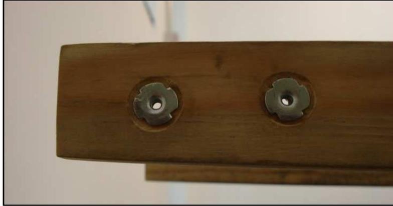
Imagen 13.21 (izquierda): Tuerca de clavar en la unión Ala Central - Ala Extremo.
